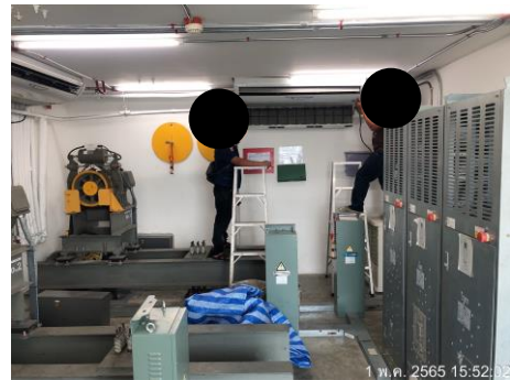
รูปที่ 2-28 ล้างแผ่นกรองและล้างเครื่องปรับอากาศส่วนกลาง
