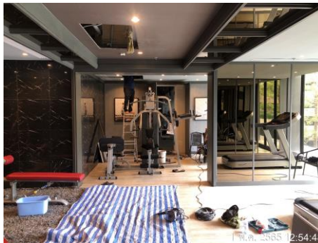
รูปที่ 2-28 ล้างแผ่นกรองและล้างเครื่องปรับอากาศส่วนกลาง
